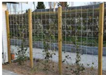
Galvaniserat armeringsnät på stolpar
